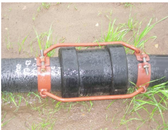
Рис. 3. Соединение труб в муфте
