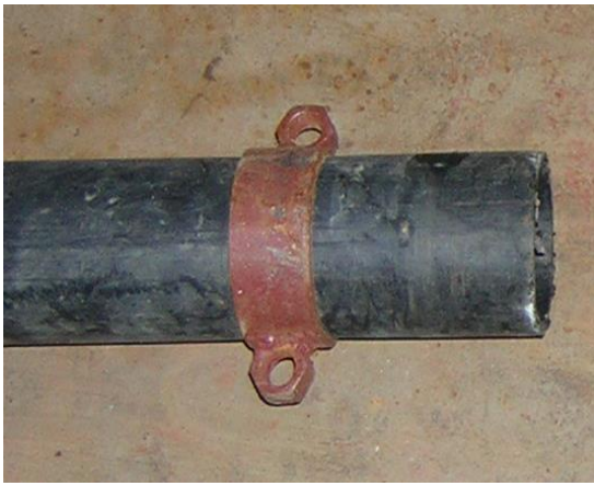
Рис. 2 Установка хомута на трубе
