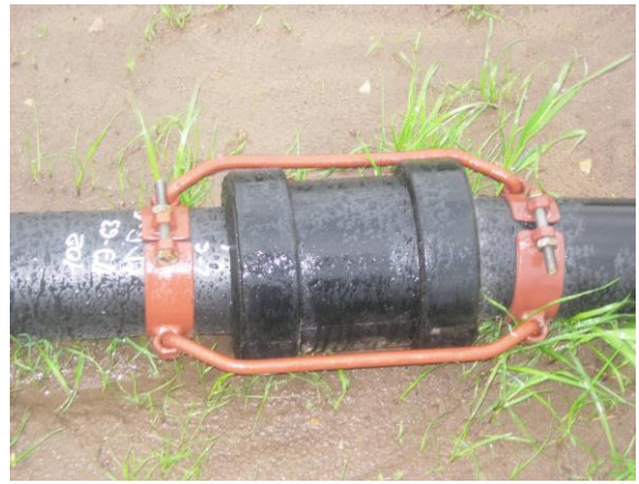
Рис. 3 Соединение труб в муфте
